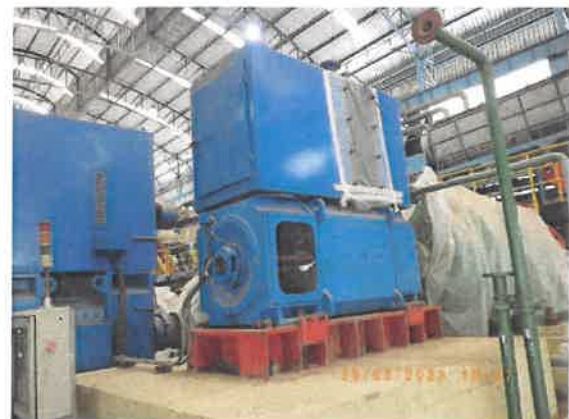
ภาพที่ 2.3-48 อุปกรณ์ลดแรงสั่นสะเทือนบริเวณฐานของ เครื่องจักร
