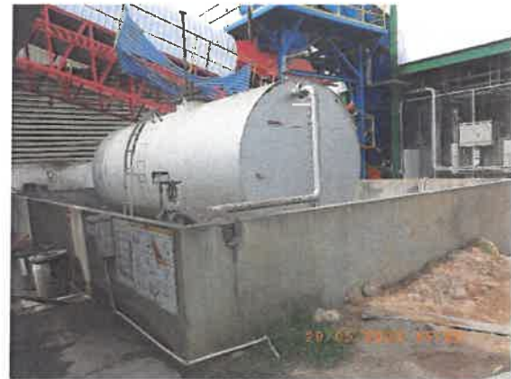
ภาพที่ 2.3-78 Bound Wall ถังเก็บน้ำมัน
