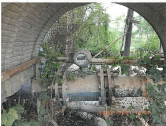
ภาพที่ 2.3-39 เวียร์หรือมิเตอร์ตรวจสอบปริมาณน้ำเสีย
